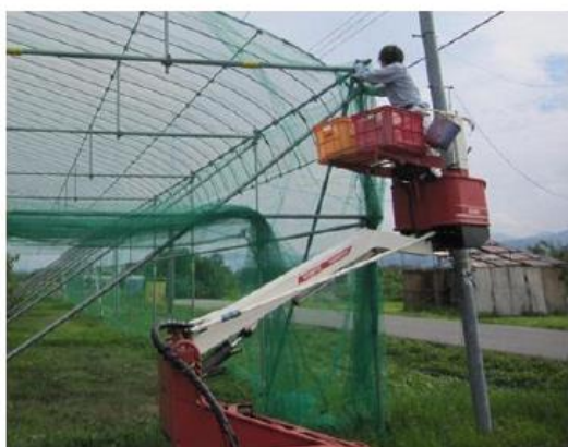
上手に使える、高所作業台車は安全で効率的な機械
